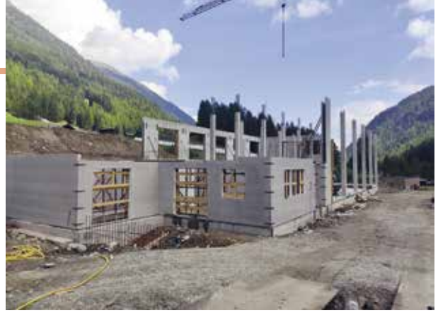
Baustelle Containerhaus Anfang September 2024
