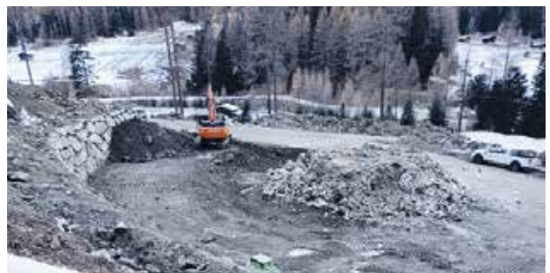
Bauarbeiten am Schneedepot
