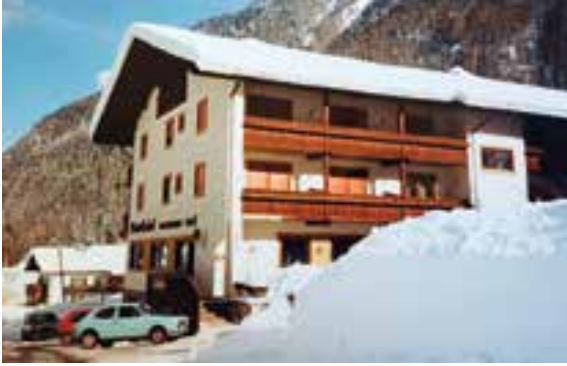
Marteller Hof nach dem Neubau
